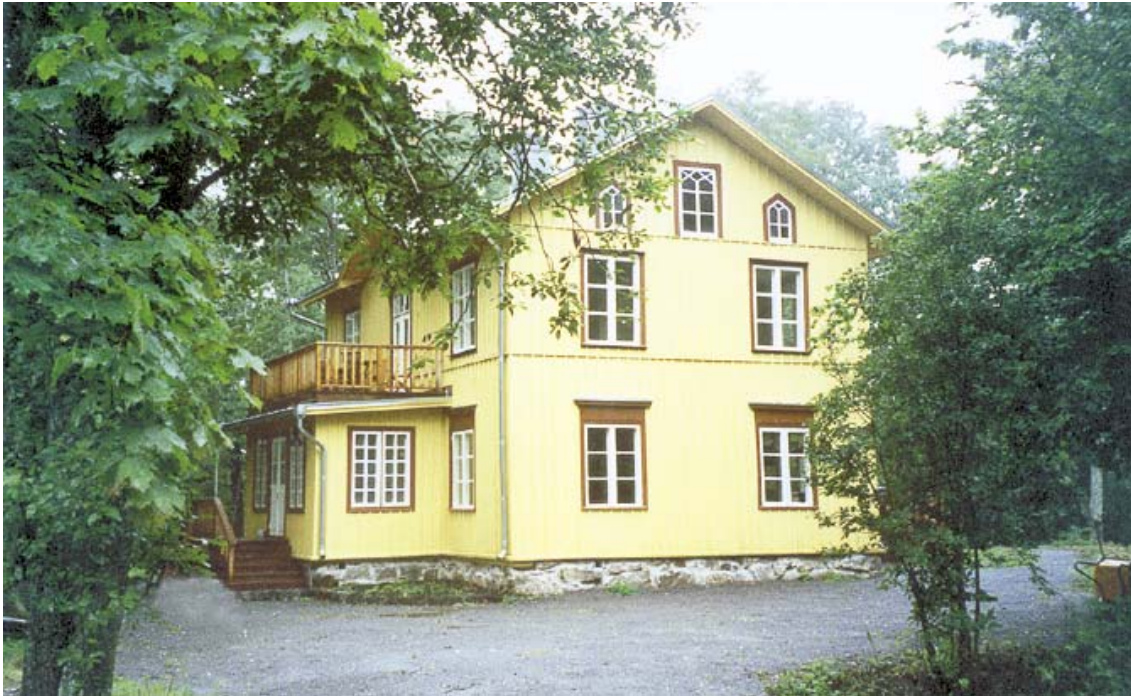
Kirjakkalan Ruukin Insinööritalo.
